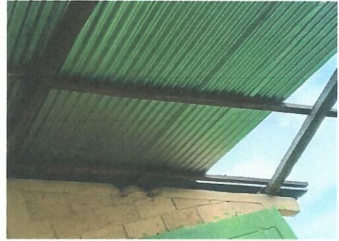
Foto 2: Mejoramiento de techo del establecimiento (colocacion de lamina y pintura de costaneras, en area de baños, dirección y bodega)
