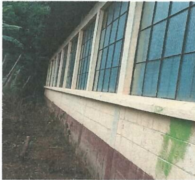
Foto 3: Mejoramiento de la pintura del establecimiento ( pintura de paredes de cada una de las aulas, dirección, baños, y bodega)
