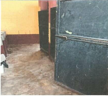
Foto1: Mejoramiento de los baños de jóvenes y señoritas (colocacion de azulejo, pizo ceramico, reparacion depuertas, ventanas y lavamanos)
